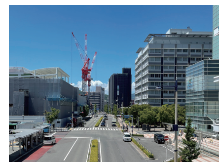
整備が進むサンポート周辺
